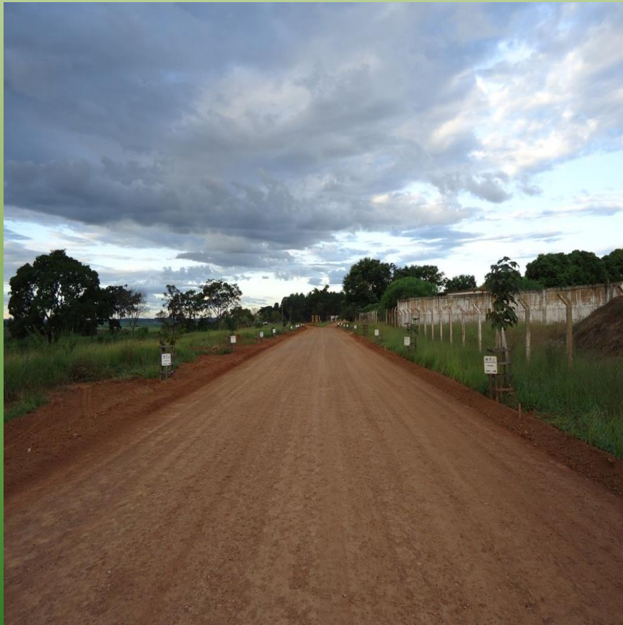
OBRA EXECUTADA EM 2010
